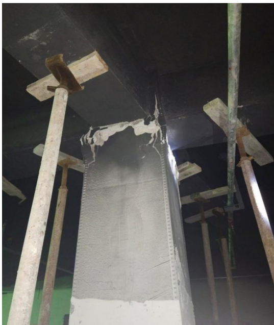
图 2 混凝土置换施工效果
