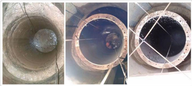
图 6 墩柱成孔、清理桩头、柱模校正照片
