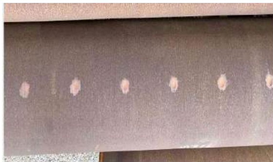
(a) 管道实物图
