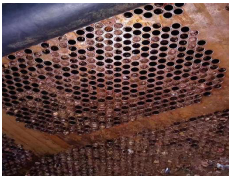
图 4 机组大修前凝汽器内部堵塞状况
